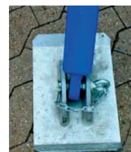
Fig. 14 Fodplade monteret og sikret.
